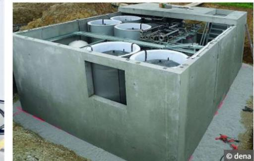
Im Ground Cube ist neben der Heizungstechnik die gesamte Gebäudetechnik vorinstalliert.
